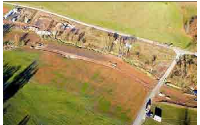
Abbildung 2: Die Versatzstelle im Gessental nach der Sanierung (unterirdische Verwahrung, Flächen- und Liniendränagen) Begrünung im November 2016
