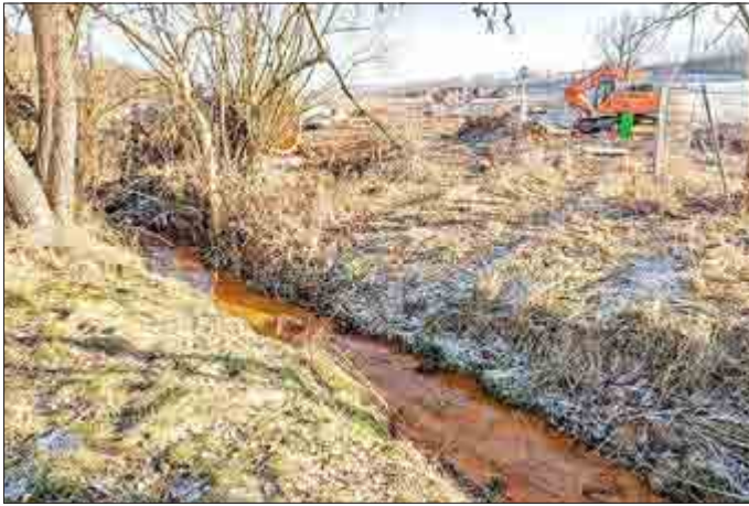
Durch Grundwasseraustritte kontaminierte Sedimente, wie auf dem Foto aus dem Jahr 2016 zu sehen, werden bei der Bachsanierung aus dem alten Bachbett abgetragen
