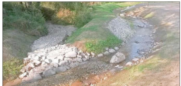
Im Auftrag der Wismut GmbH sanierter Gessenbach, neu trassierter Bachlauf mit Störsteinen (Vordergrund und rechte Bildhälfte) und Altarmbiotop (linke Bildhälfte)
