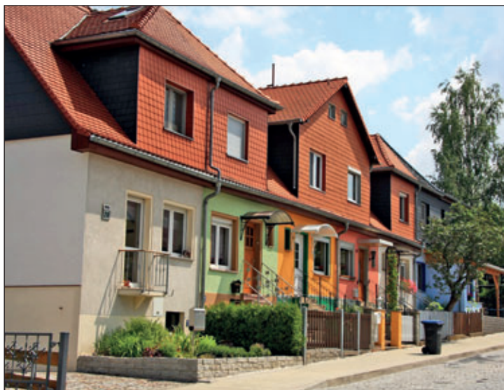
Die sechs Baugenossenschaftshäuser, wie sie heute anzusehen sind. Foto: Klaus Kammel
