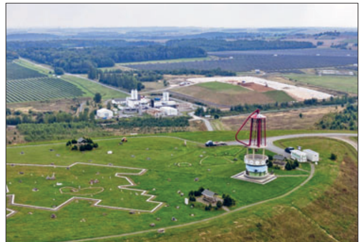
Schmirchauer Höhe des Tagebauaufschüttkörpers mit Grubenlampe, im Hintergrund Offenland- und Aufforstungsflächen, Wasserbehandlungsanlage, Immobilisat-lager und Solarenergieflächen
