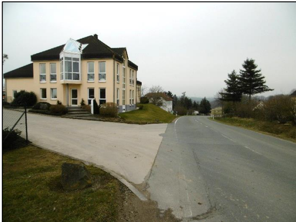
Abbildung 8: Verwaltungsgebäude und Zufahrt westlich des Plangebietes
